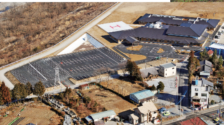
▼新病院完成時の全景。大きな駐車場と平屋建ての病棟が新鮮だ。中央奥にはヘリポートも見える
